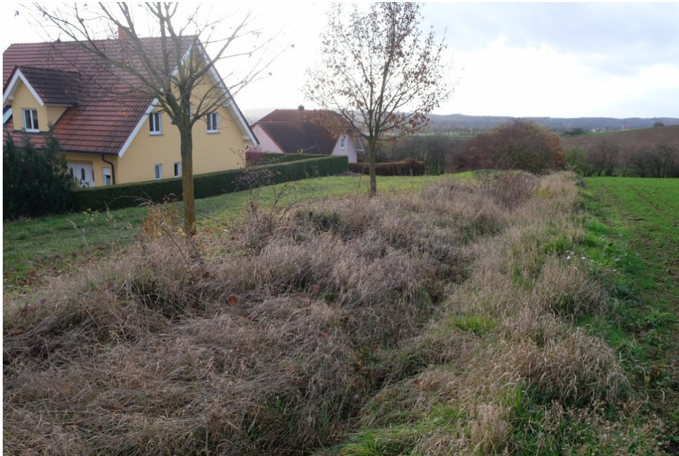
Abbildung 5 Aktueller Schutz der Wohnbebauung durch Graben und Pufferstreifen oberhalb der Abt-Mahlmeister-Straße
