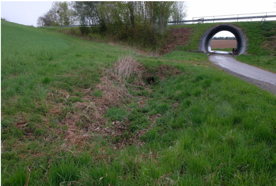
Abbildung 9 Möglicher Standort für eine Rückhaltung am Riedengraben. Foto: R. Vandr , Mai 2021.
