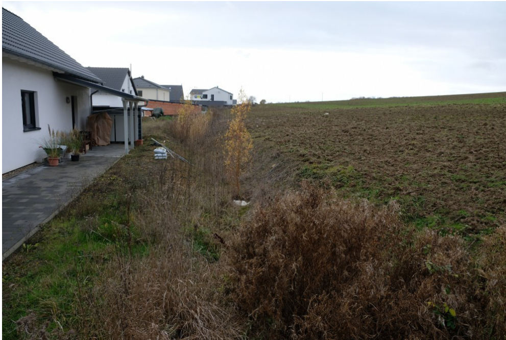
Abbildung 6 Aktueller Schutz der Wohnbebauung durch Graben und Pufferstreifen oberhalb der Conrad-Geiger-Straße
